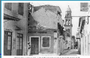
041-123 ΑΡΓΟΣΤΟΛΙ - ΛΙΘΟΣΤΡΩΤΟ ΣΤΟΝ ΑΓ ΣΠΥΡΙΔΩΝΑ 1930
