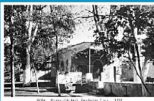
053-035 ΘΗΒΑ - ΜΟΣΧΟΠΟΔΙ - ΕΚΚΛ ΖΩΟΔΟΧΟΣ ΠΗΓΗΣ 1950
