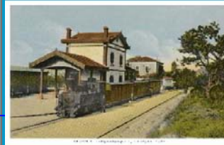
029-050 ΛΕΧΩΝΙΑ - ΣΙΔΗΡΟΔΡΟΜΙΚΟΣ ΣΤΑΘΜΟΣ 1907
